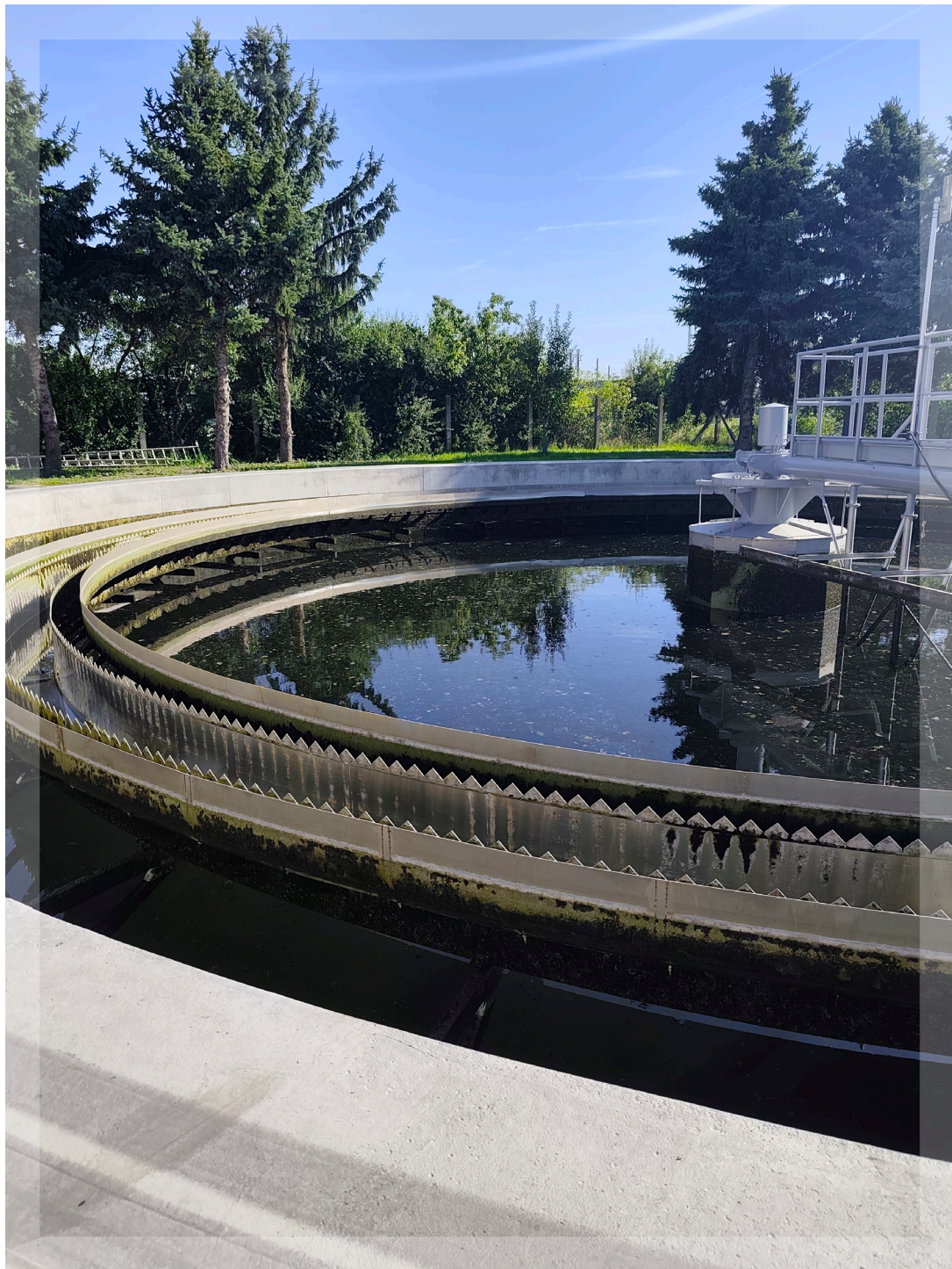
ČOV Kyjov - dosazovací nádrž I
